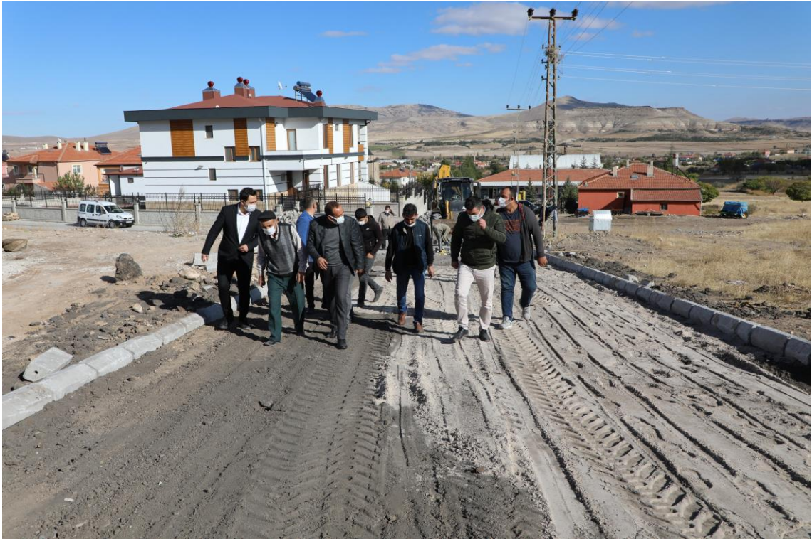
Süksün Mahallemizde Yapılan Parke Yapımı Çalışması
