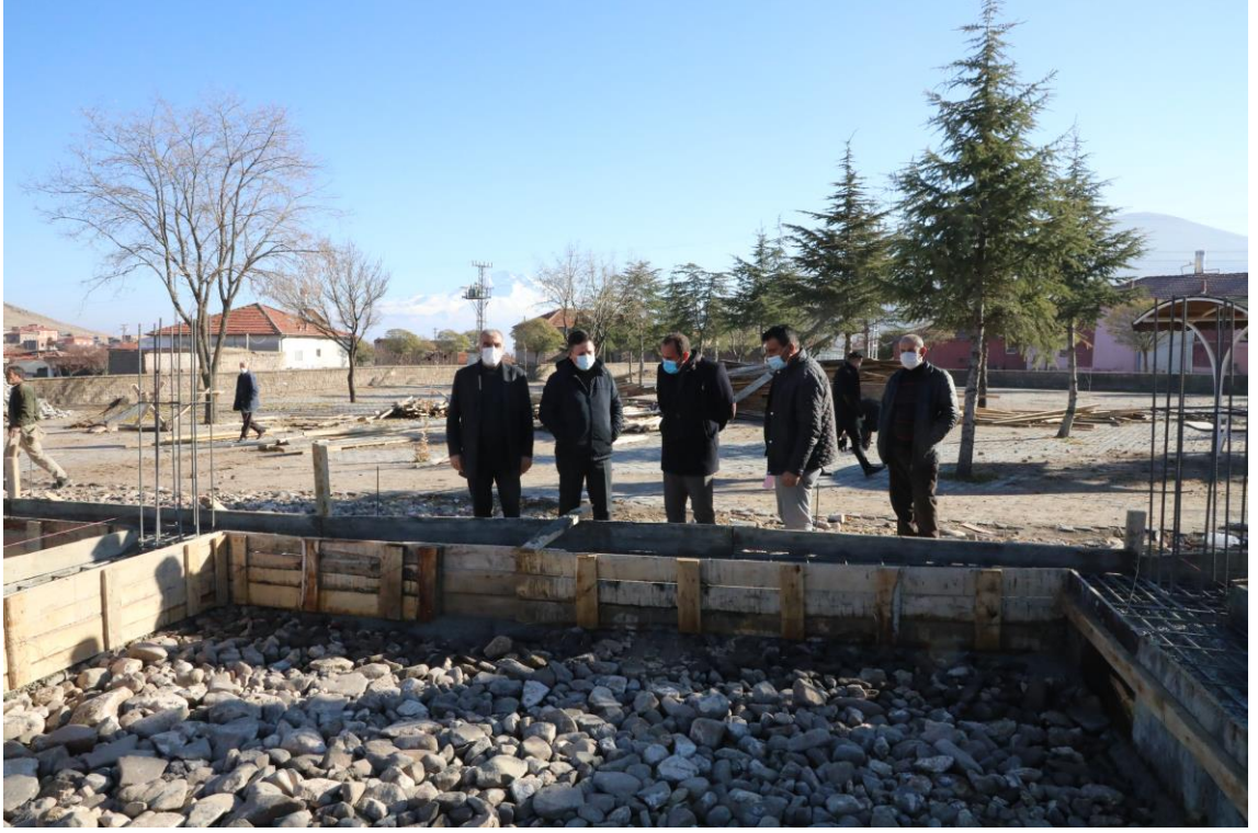
Garipçe Mahallemiz Sosyal Tesis Ek Bina Yapımı
