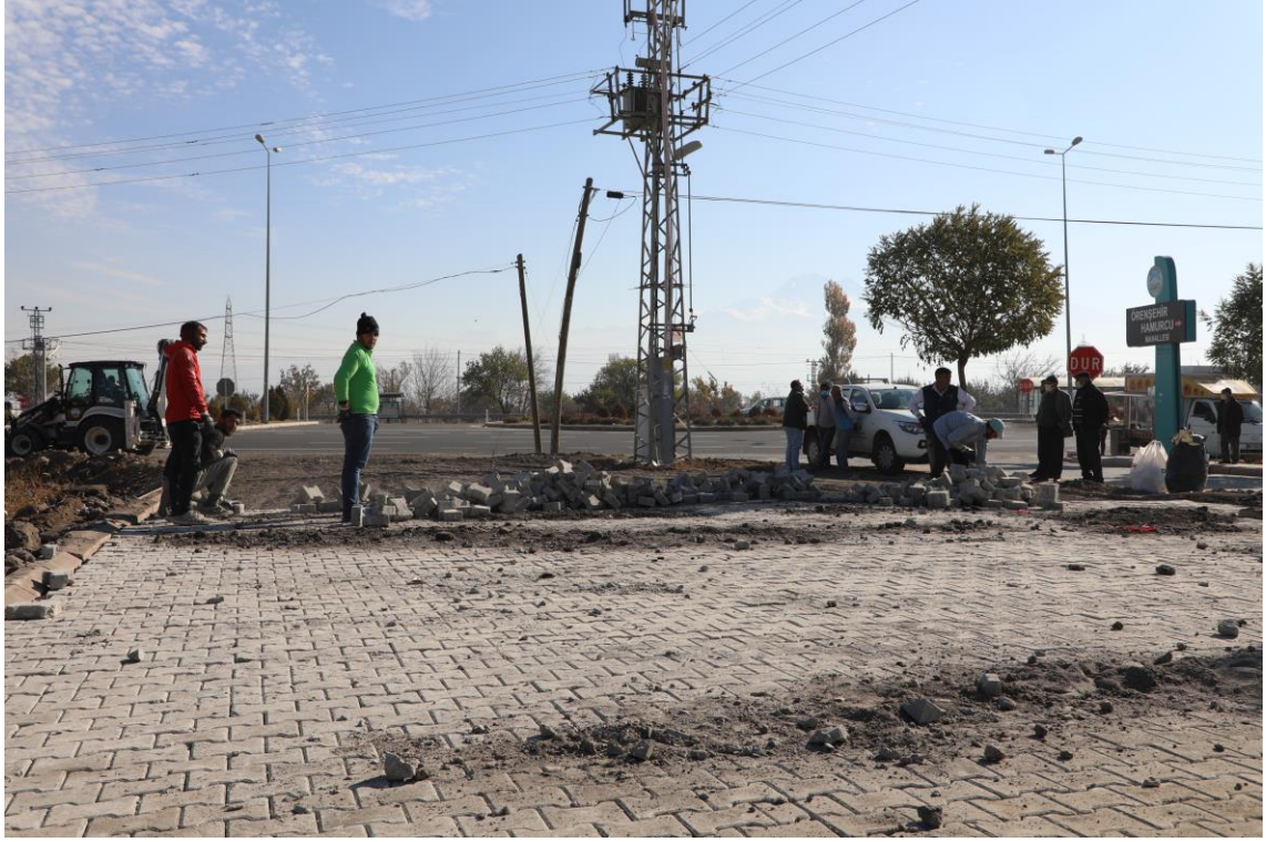
Örenşehir Mahallemiz Kapalı Durak Alanı Parke Yapımı
