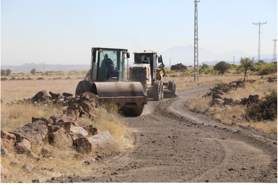
Omaç'ca Arazi Yolu Yapımı Çalışması
