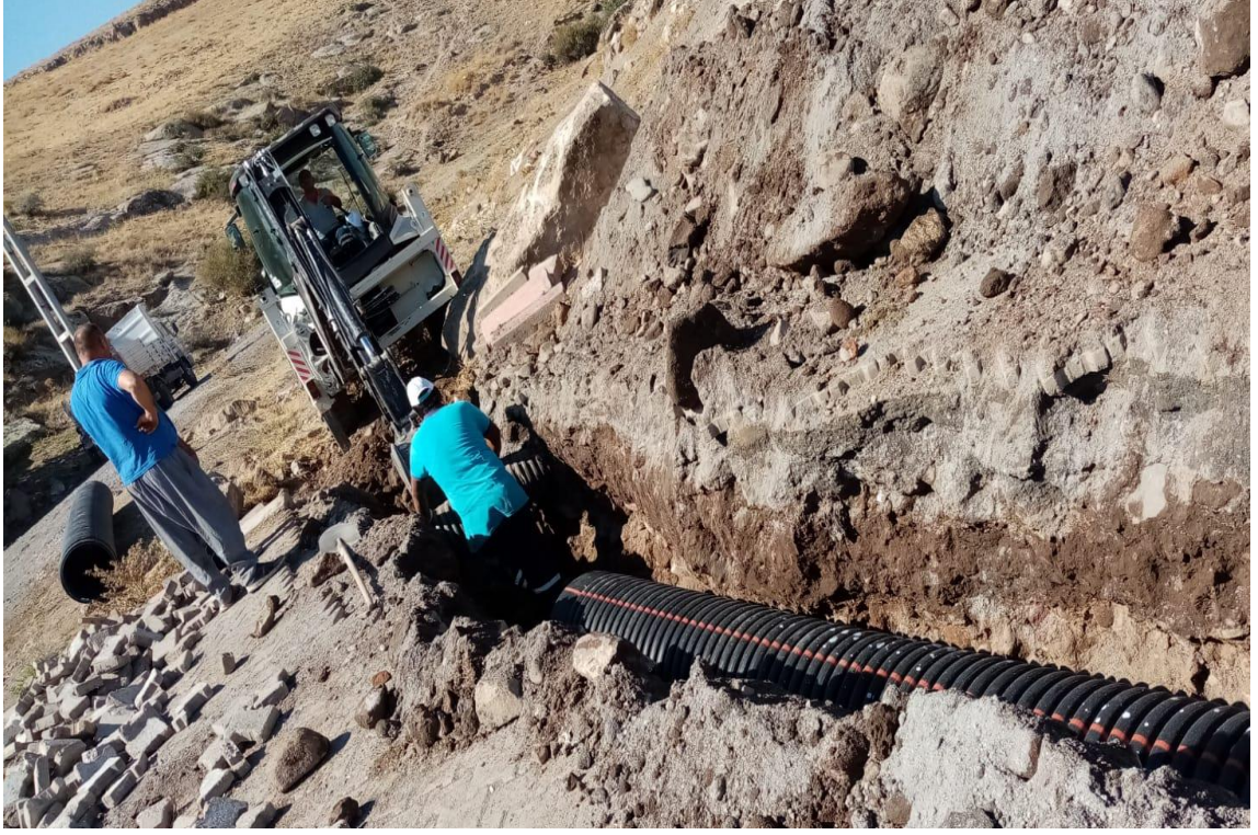
Tekke Dağı Yolu Korige Boru Çalışması
