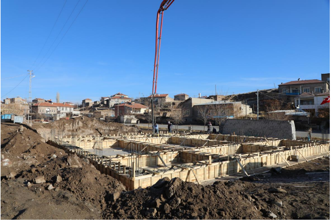
Üçkuyu Mahallemiz Sosyal Tesis Yapımı
