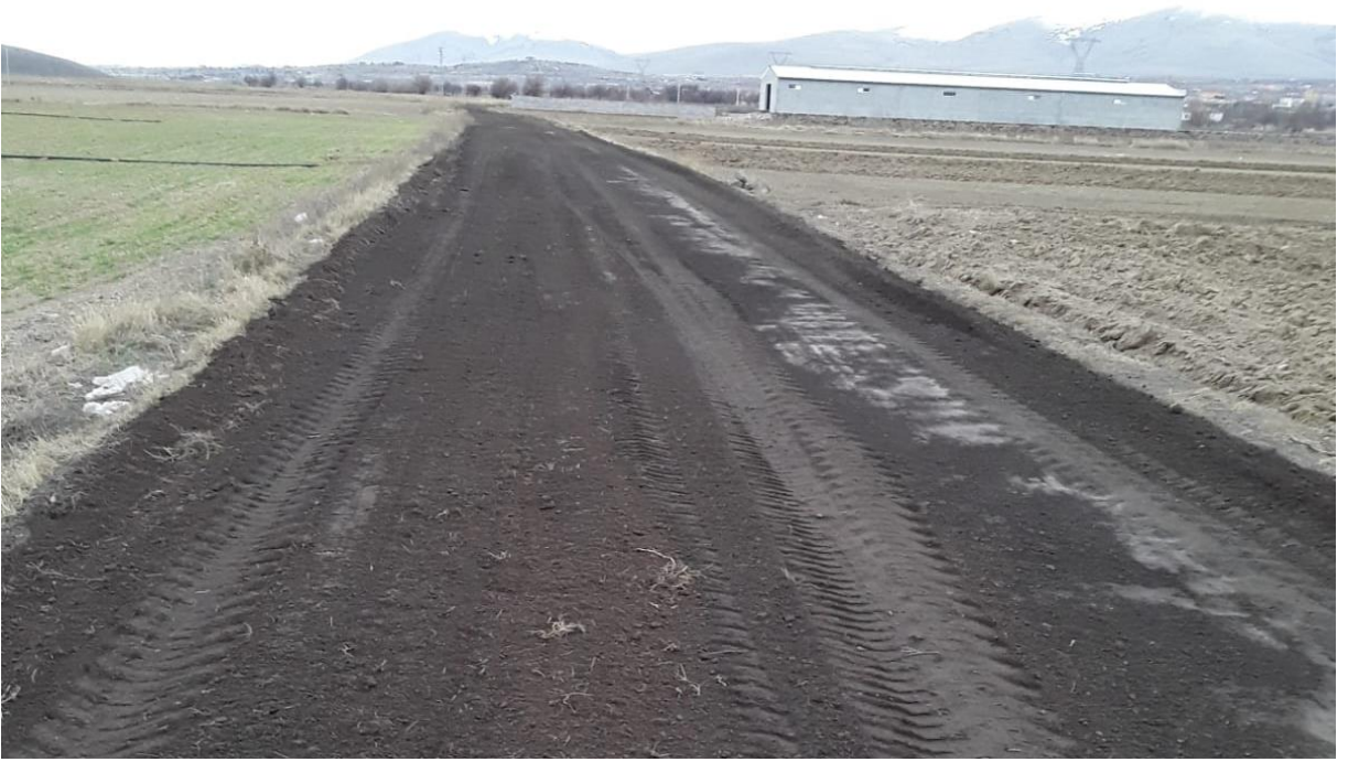
İstasyon Mevki Arazi Yolu Çalışması
