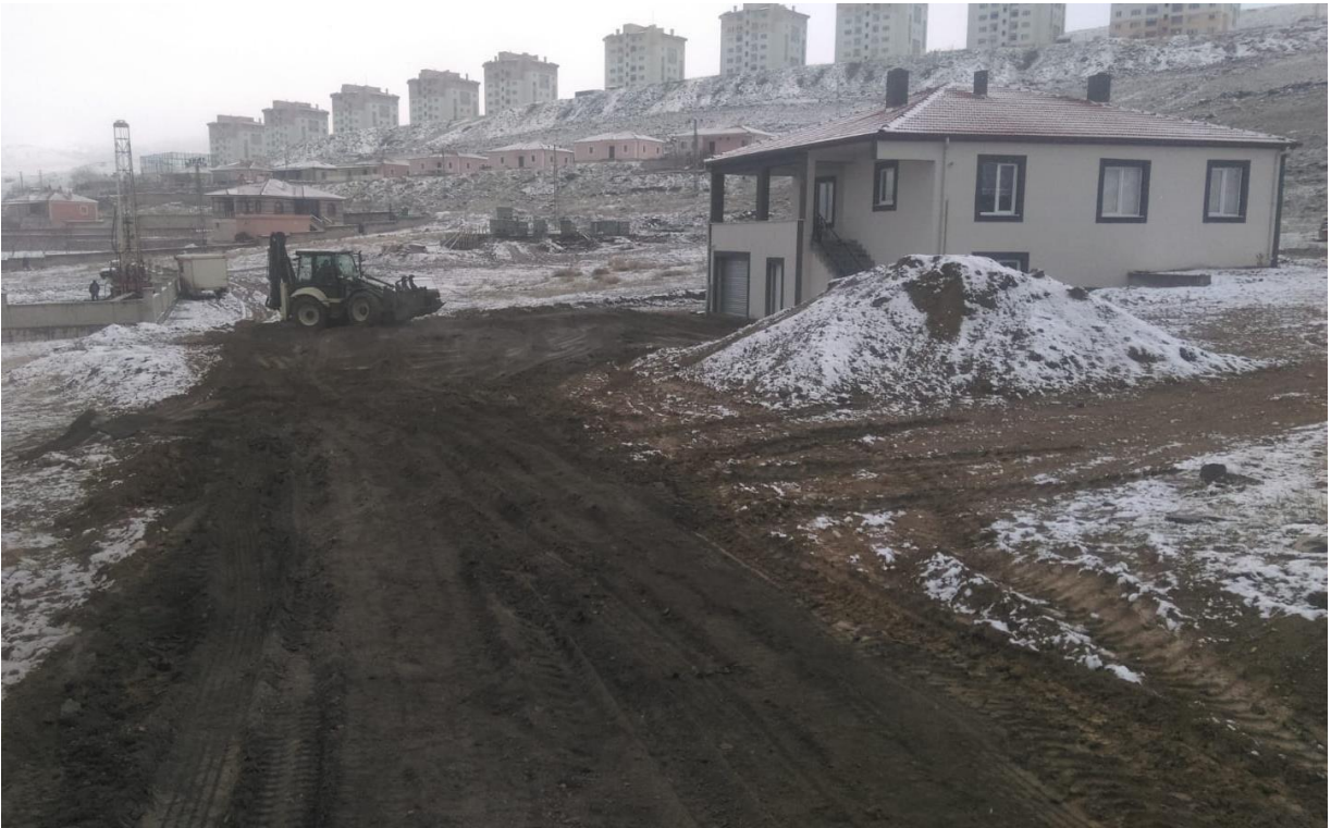
Süksün İmar Yolu Yapımı Çalışması
