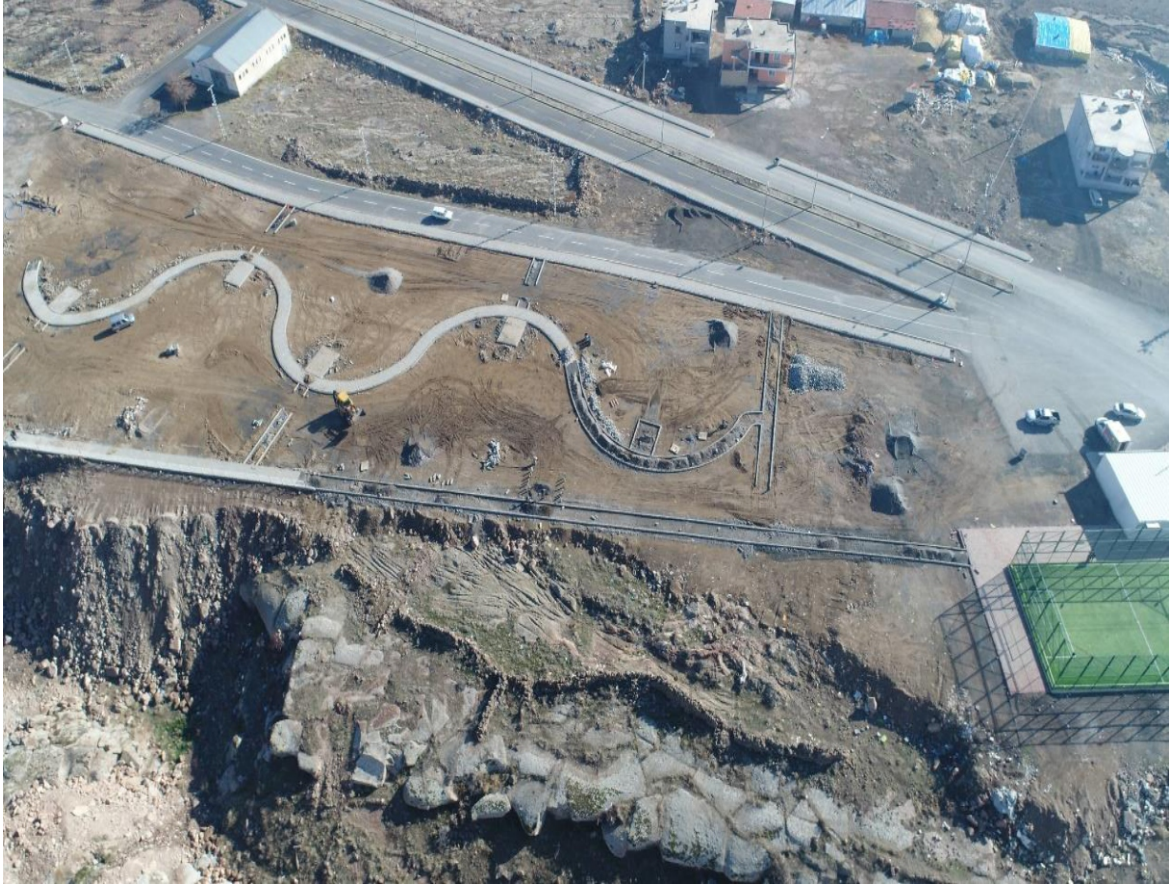
3. Etap TOKİ Konutları Park Yapımı Çalışmaları
