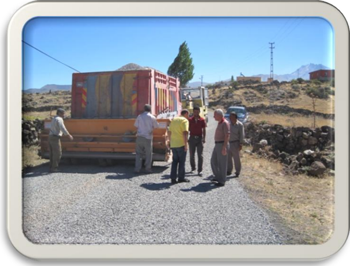
Kızılören Mahallesi Asfalt Çalışması
