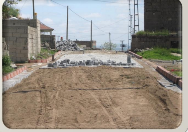
Örenşehir Mahallesi Sokaklarının Parke Çalışması
