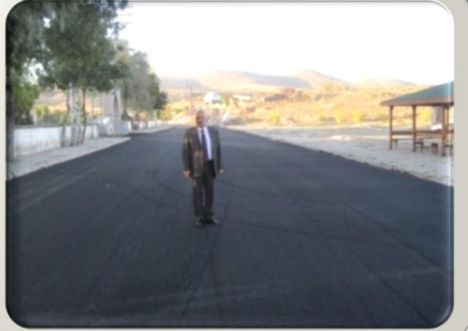
İlçe Mezarlığı Yolu Sıcak Asfalt Çalışması
