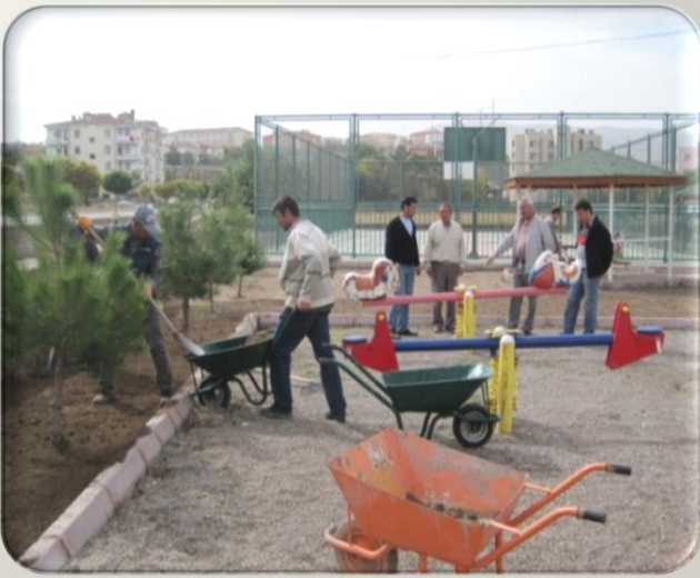
Kara Mustafa Paşa Mahallesinde Park bakım çalışması
