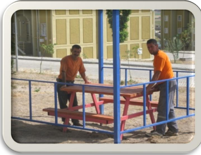
2.Etap Toki Çevre Düzeni ve Kamelya Yapımı
