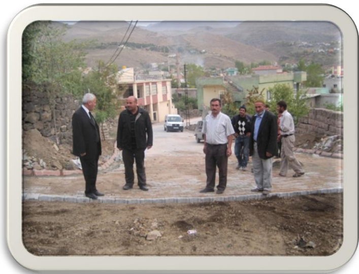
Kızılören Mahallesi Parke Çalışması
