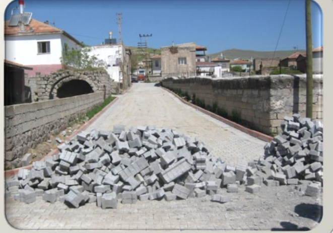
Örenşehir Mahallesi Sokaklarının Parke Çalışması
