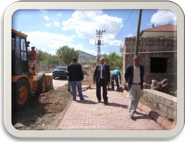
Kızılören Mahallesi Parke Çalışması
