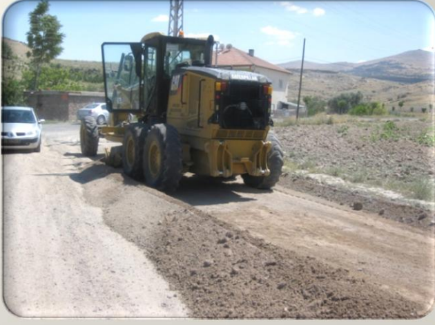
Süksün Mahallesi Parke Çalışması
