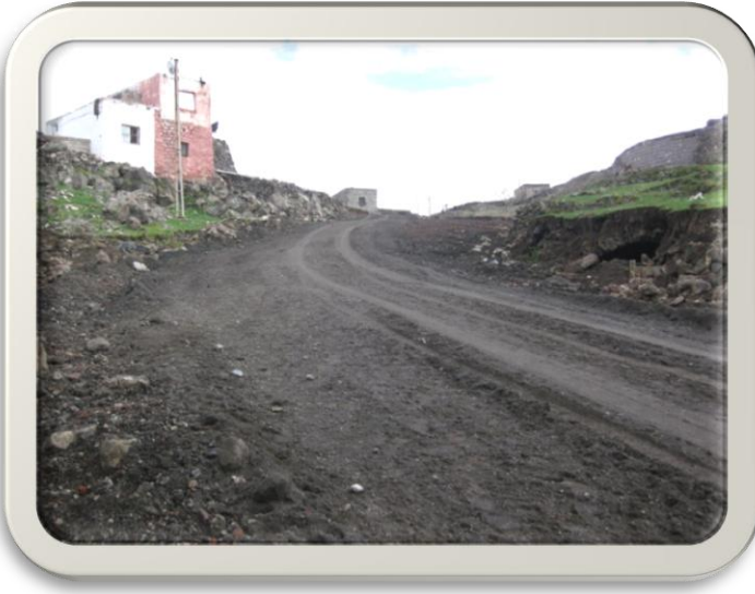
Kızılören Stabilize Yol Yapım Çalışması
