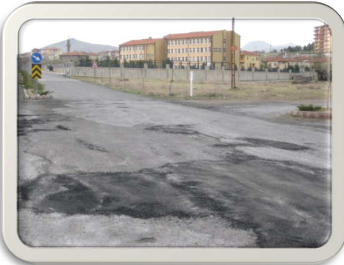
Semerkent Mahallesi Yol Tamir Çalışması
