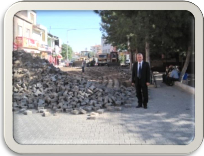
K.M.P. Mahallesi İstiklal Caddesi Parke Çalışması
