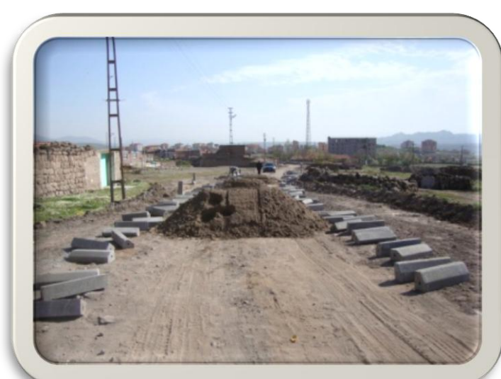
Fırınönü Mahallesi Islah Evi Yol Çalışması
