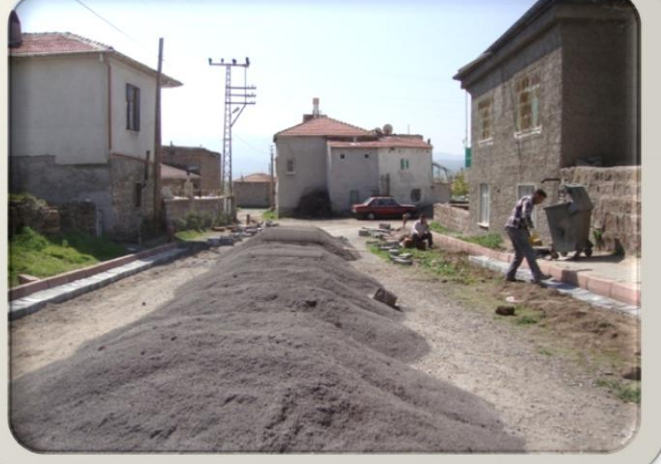
Örenşehir Mahallesi Sokaklarının Parke Çalışması
