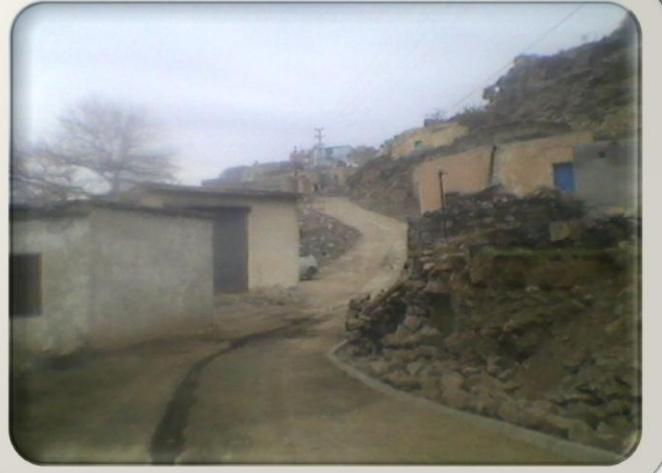
Süksün Mahallesi Parke Çalışması
