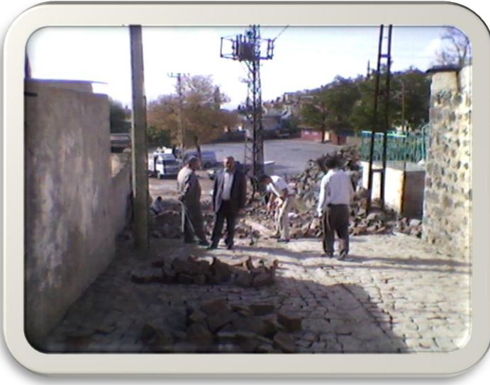
Kızılören Mahallesi Parke Çalışması
