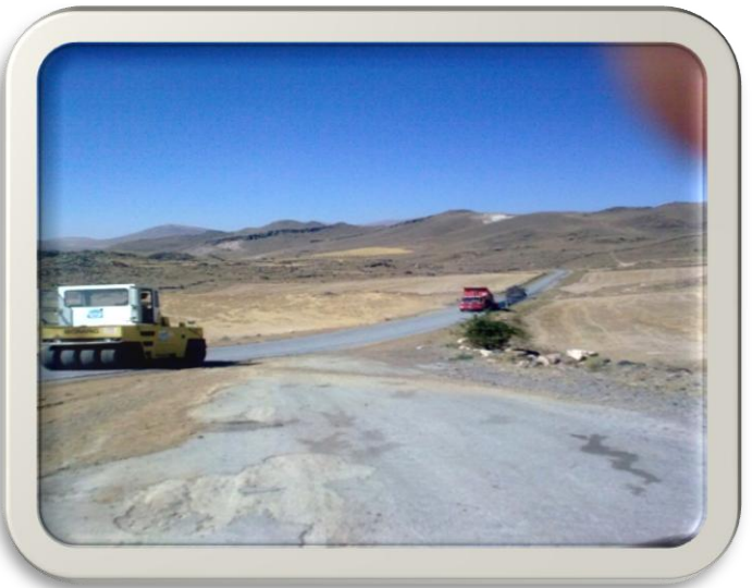
Kızılören Mahallesi Asfalt Çalışması
