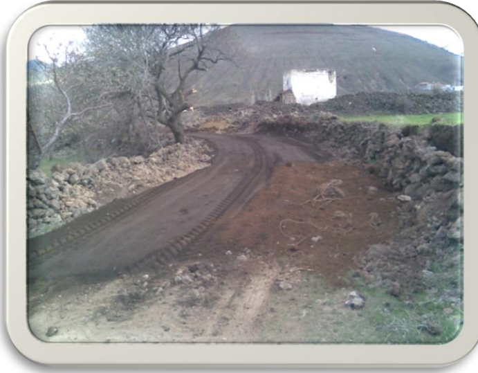
Kızılören Mahallesi Stabilize Yol Yapım Çalışması
