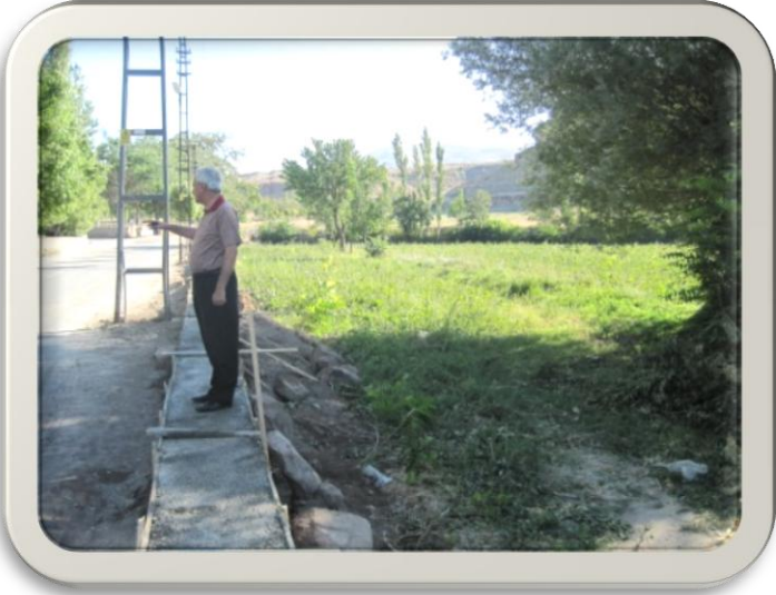
Karakoyunlu Mahallesi Bahçe Duvarı Yapım Çalışmaları
