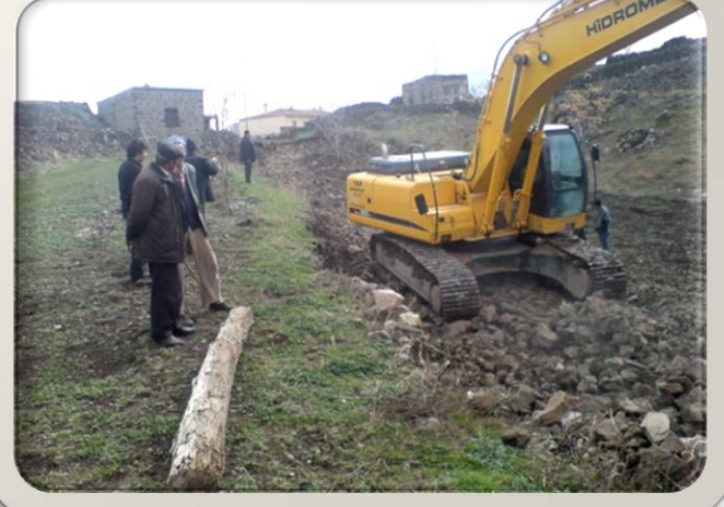
Kızılören Mahallesi Yol Geniřletme alıřmaları
