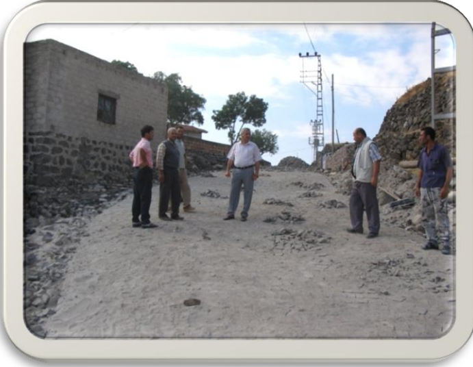
Çardaklı Mahallesi Parke Çalışması
