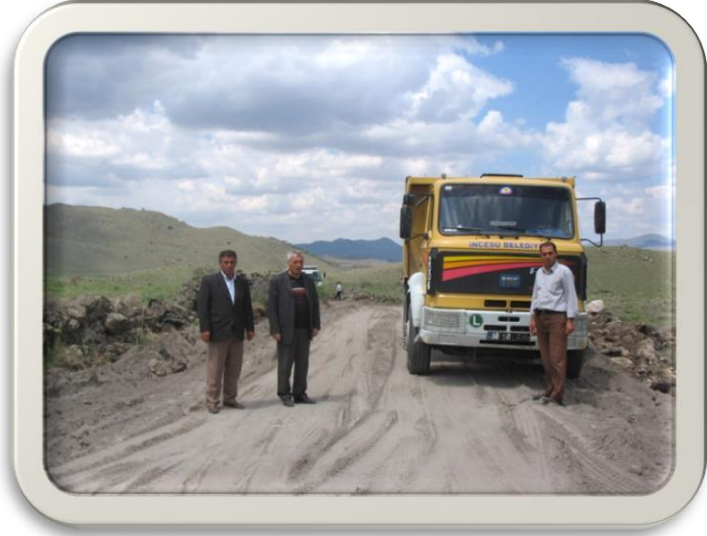
Çardaklı Mahalleleri Arası Bağlantı Yol Çalışması
