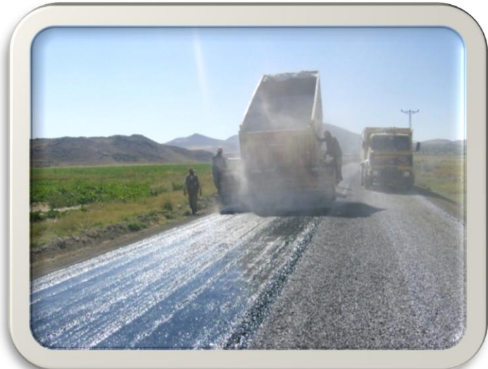
Dokuzpınar Yolu Asfalt Çalışması
