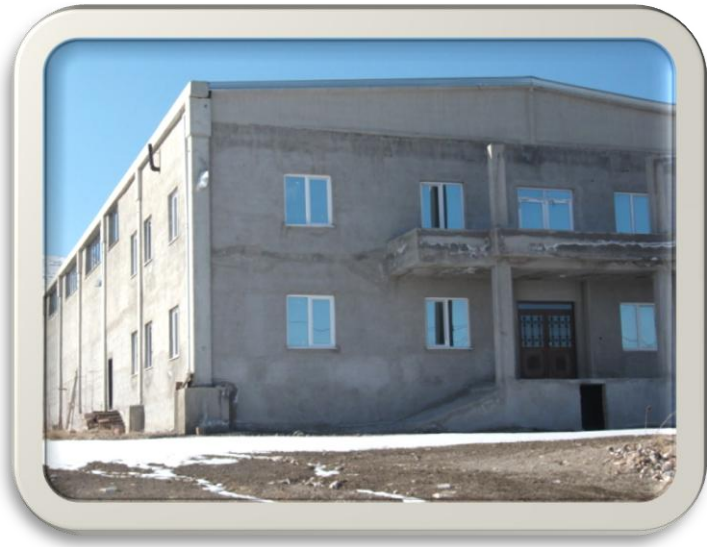
Organize Sanayi Bölgesinde Yapılmakta Olan Fabrika İnşaatı
