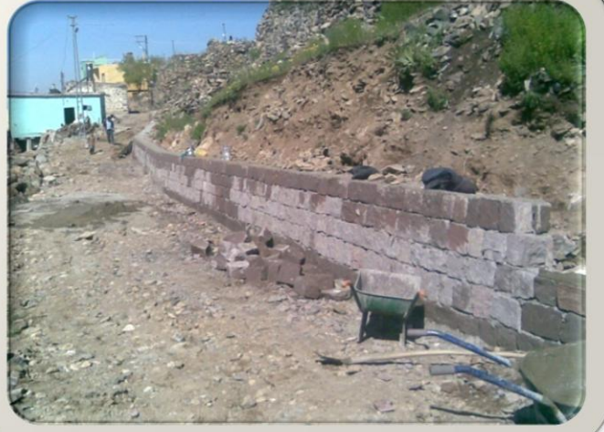
Kızılören Güney Mahallesi Duvar Yapımı
