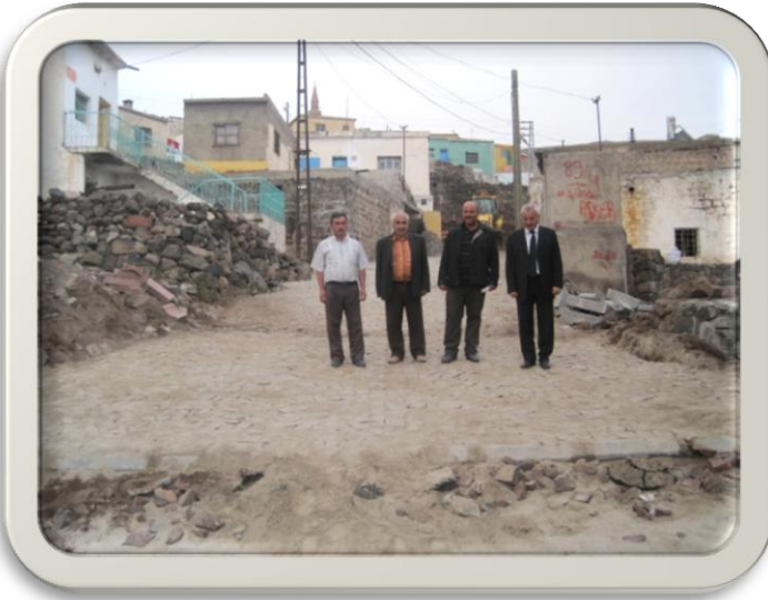
Kızılören Mahallesi Parke Çalışması
