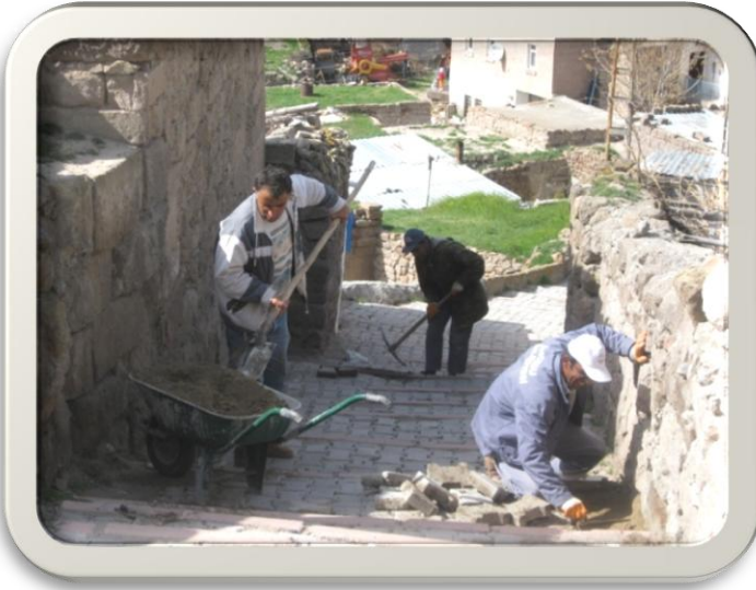
Fırınönü Mahallesi Ara Sokak Kaldırım Parke Çalışması
