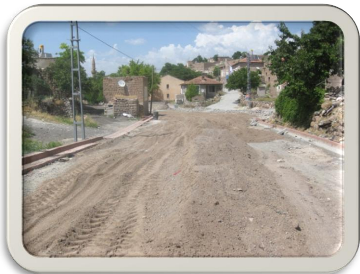
Süksün Mahallesi Parke Çalışması
