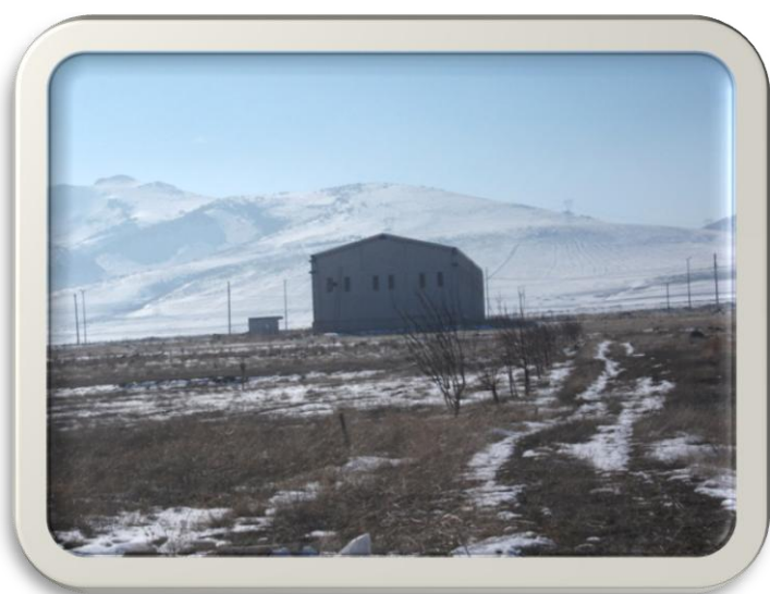
Organize Sanayi Bölgesinde Yapılmakta Olan Fabrika İnşaatı
