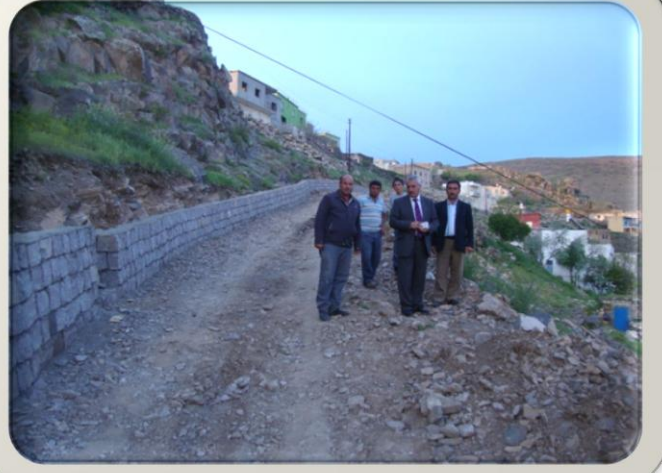
Kızılören Gney Mahallesi Yol Geniřletme alıřmaları
