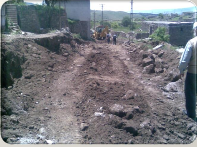
Kızılören Mahallesi Yol Geniřletme alıřmaları
