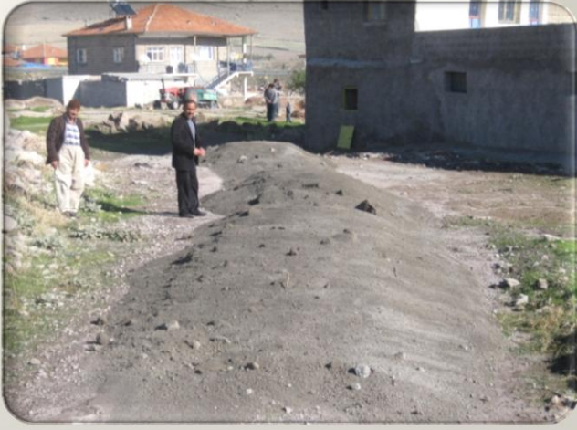
Garipçe Mahallesi Yol Yapımı
