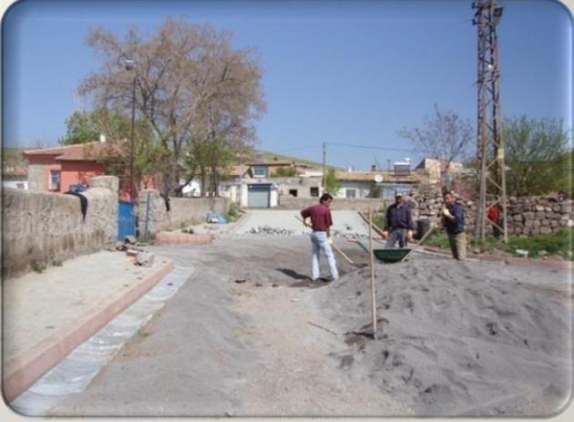
Örenşehir Mahallesi Sokaklarının Parke Çalışması
