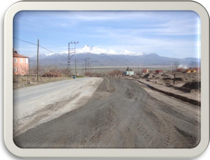
Süksün Bedir Bağları Yol Genişletme Çalışması
