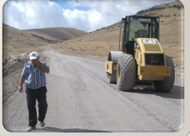
Kızılören Mahallesi Stabilize Yol Yapım Çalışması
