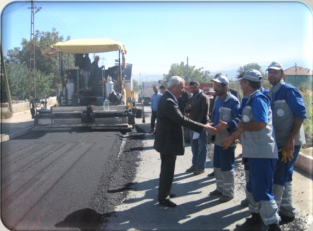
Örenşehir Mahallesi Sıcak asfalt Çalışması
