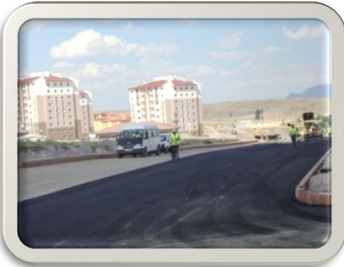
Gönenken Mahallesi 1.ve2. Etap Toki Arası Sıcak Asfalt Çalışması
