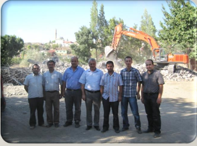
Kızılören Mahallesi Yol Geniřletme alıřmaları
