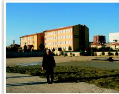
Anadolu Lisesi Basketbol Sahası Yapımı
