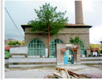
Umumi Tuvalet ve Bahçe Onarımı
