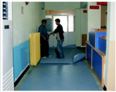
Hizmet Binası Onarımı
